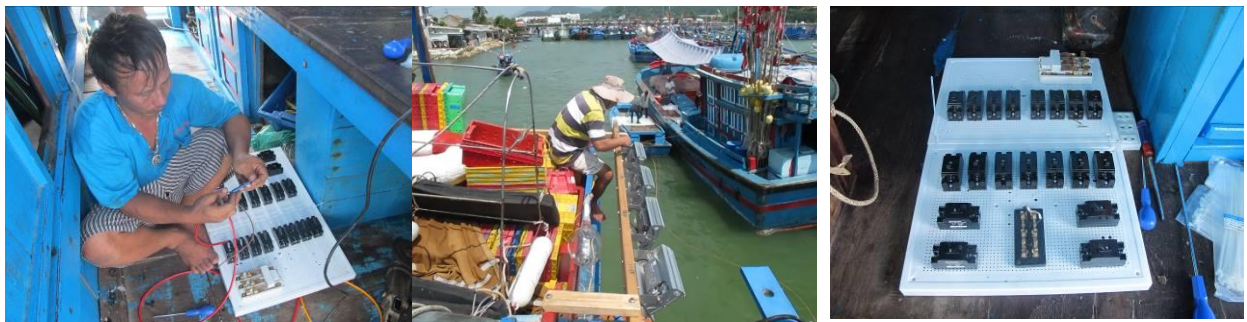
Hình 3.6: Lắp đặt hệ thống dây và bảng điện
