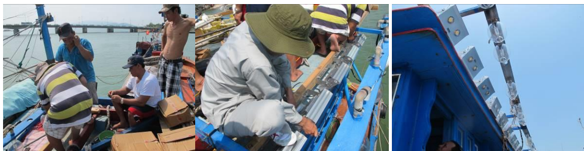
Hình 3.4: Lắp đặt đèn LED trên tàu thực nghiệm
