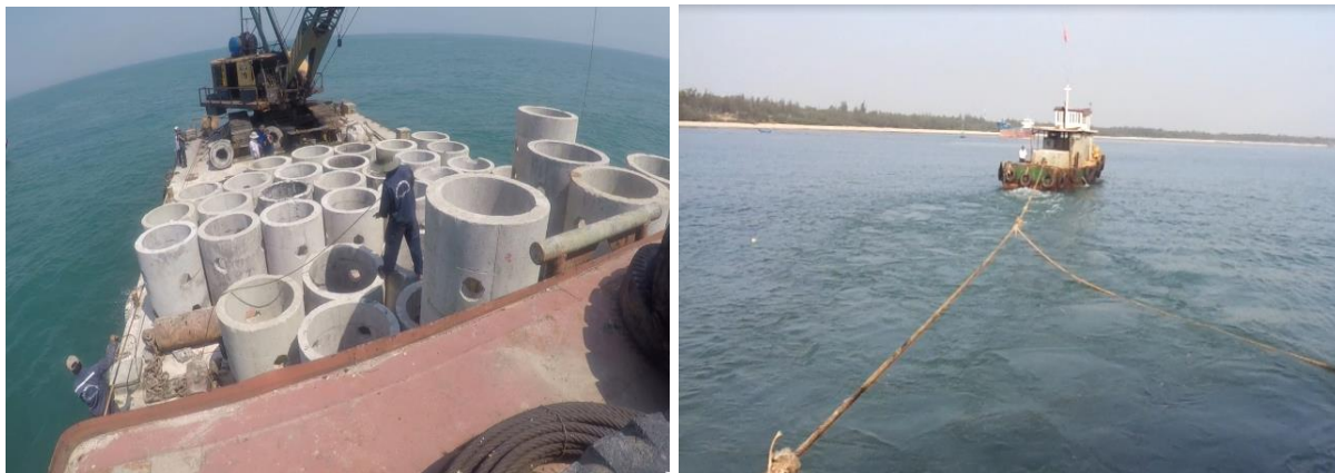
Hình 3.9: Sắp xếp rạn lên sà lan và vận chuyển đến khu vực lắp đặt
