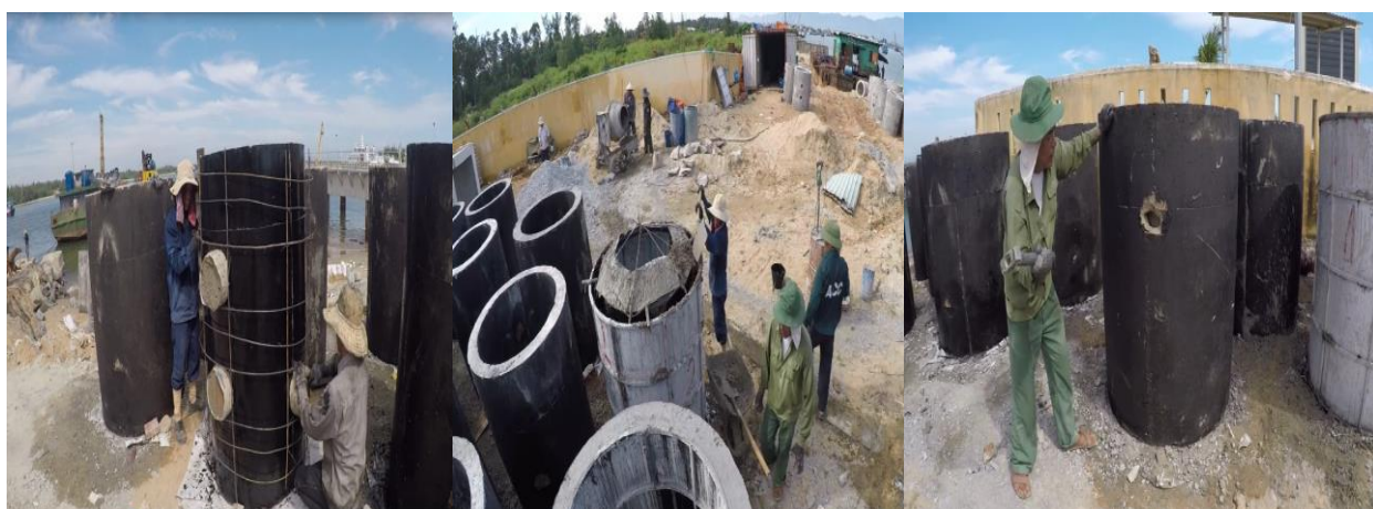
Hình 3.6: a-Lắp đặt khuôn đúc rạn; b- Đổ vữa vào khuôn rạn, c- Hoàn thiện rạn
